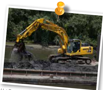
Het Durmezand moet eerst drogen alvorens het als bouwstof kan aangewend worden (baggerwerken Durmevallei).
