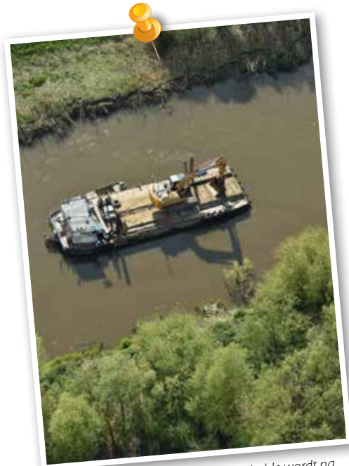
De baggerspecie uit de Boven-Zeeschelde wordt na het toevoegen van specifieke stoffen rechtstreeks gebruikt als bouwstof voor de dijken (baggerwerken Heusden).
